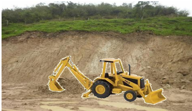
Figura 3. Extracción de Arcillas con Retroexcavadora
