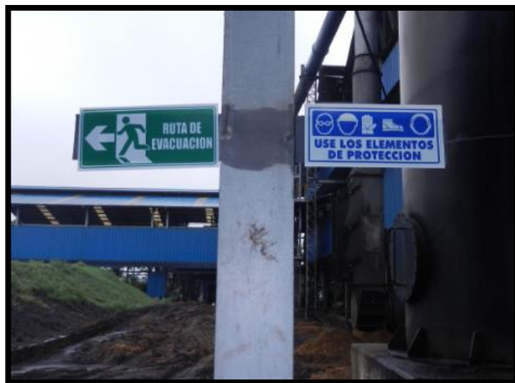
Figura 71. Señalización de emergencia
