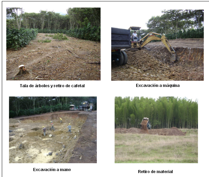
Figura 14. Registro fotográfico de las actividades preliminares y de excavación del edificio de aulas.
