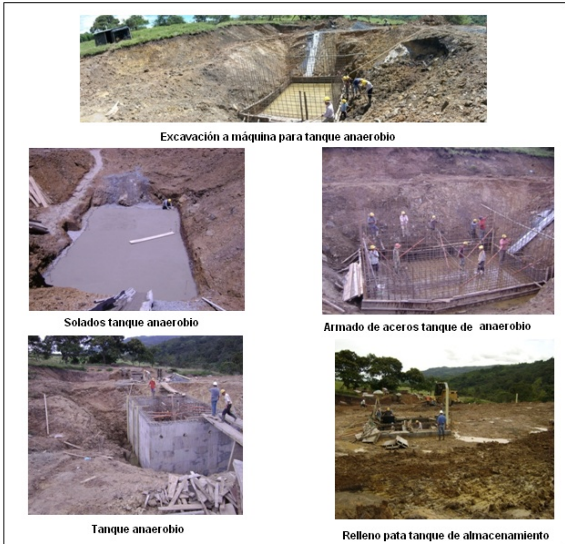
Figura 31. Registro fotográfico del seguimiento de la construcción del tanque anaerobio de la planta de tratamiento de aguas residuales.
