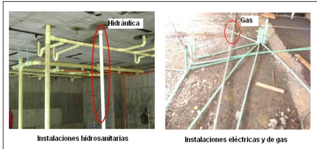
Figura 21. Registro fotográfico de instalación de tuberías del edificio de aulas
