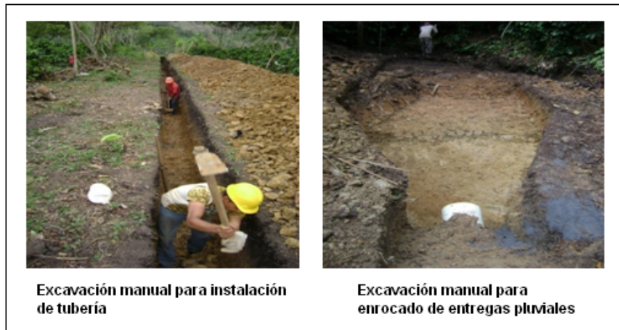
Figura 23. Registro fotográfico para la actividad de excavación en la acometida general
