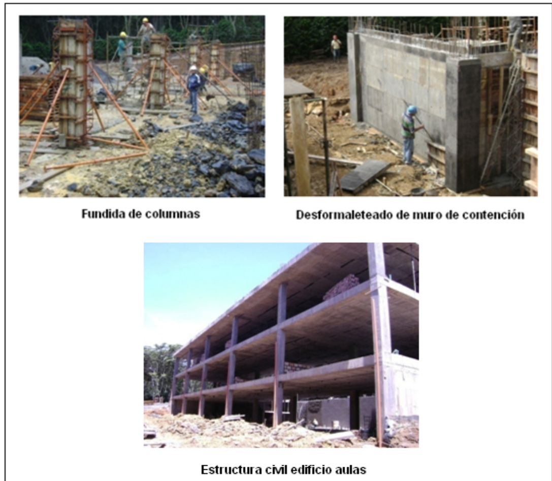
Figura 16. Registro fotográfico de la actividad de armado y fundida de columnas y muro de contención del edificio de aulas.
