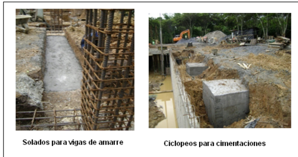
Figura 15. Registro fotográfico de la actividad de cimentación en el edificio de aulas
