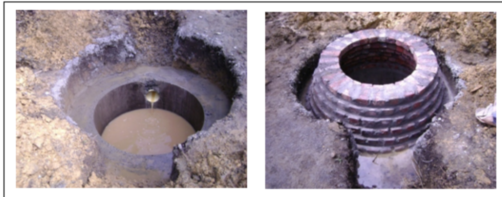
Figura 25. Registro fotográfico construcción de pozos de inspección
