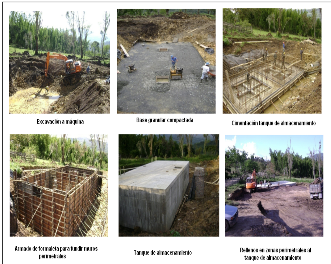
Figura 28. Registro fotográfico de la construcción del tanque de almacenamiento
