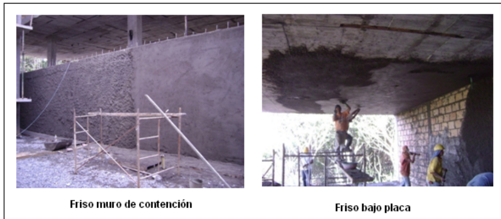
Figura 20. Registro fotográfico de la actividad de frisos para el edificio de aulas
