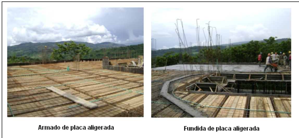
Figura 17. Registro fotográfico de la actividad de armado y fundida de la placa aligerada del edificio de aulas
