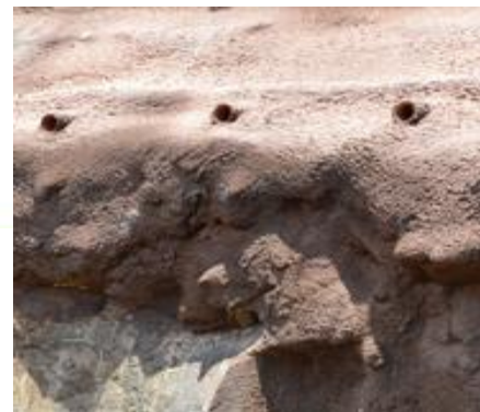
Figura 12. Sistema de drenes en un talud [11]
