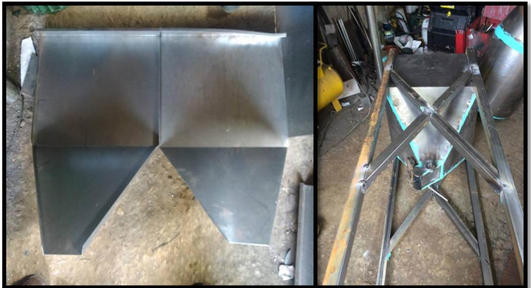
Figura 55: Construcción, ensamblaje tolva y soportes.
