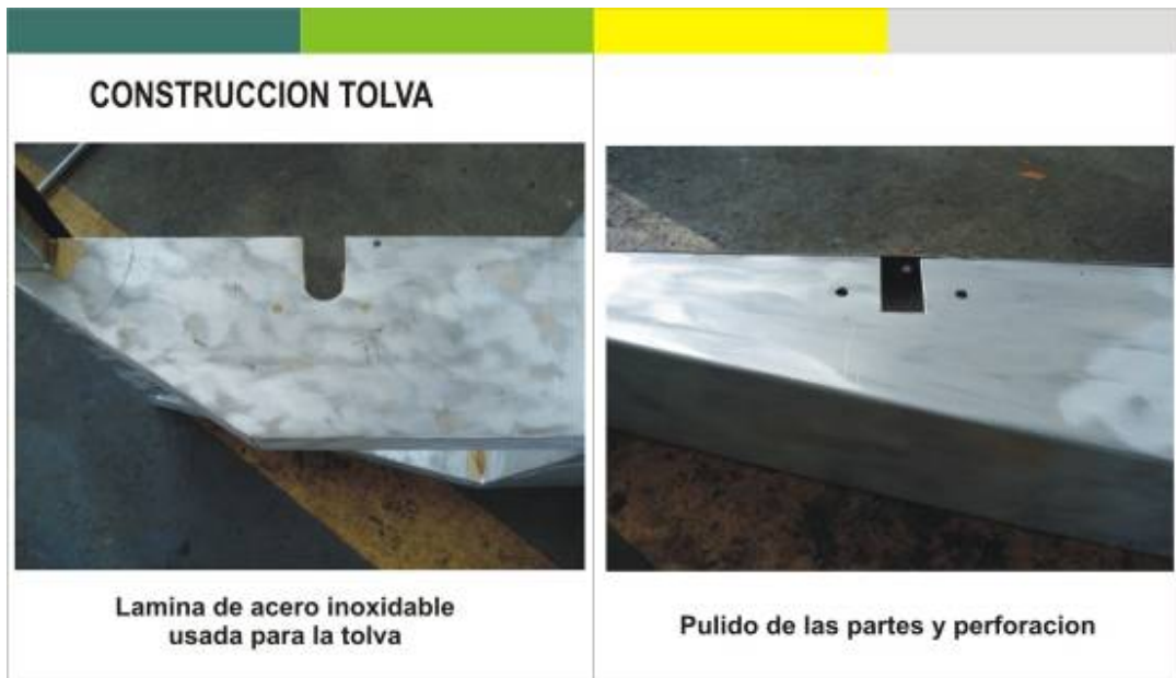
Figura144. Construcción de la tolva
