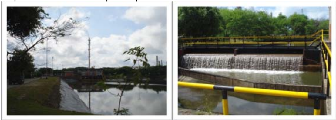
Figura 18 – 19 Primera etapa de la piscina pulmón retención del fluido
