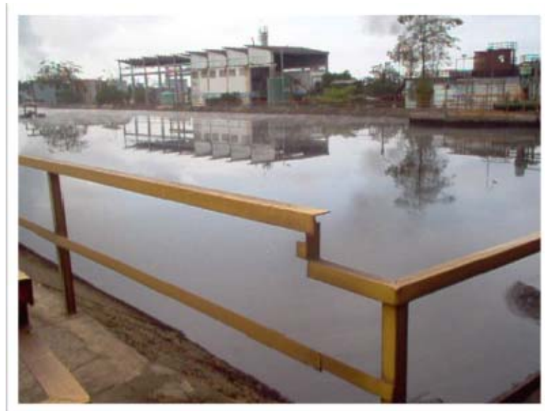
Figura 29. Piscinas de estabilización BA-4009 A/B.
