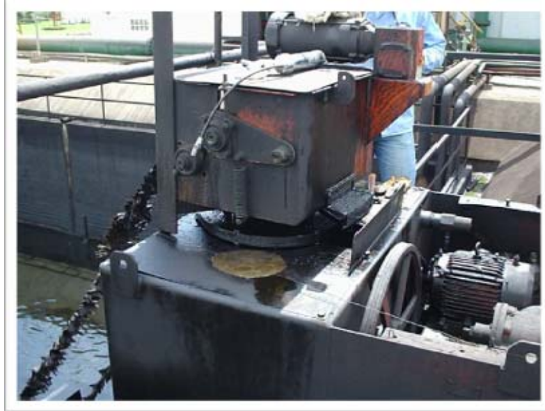
Figura 35. Carcaza en lamina coll roll de 1/4"
