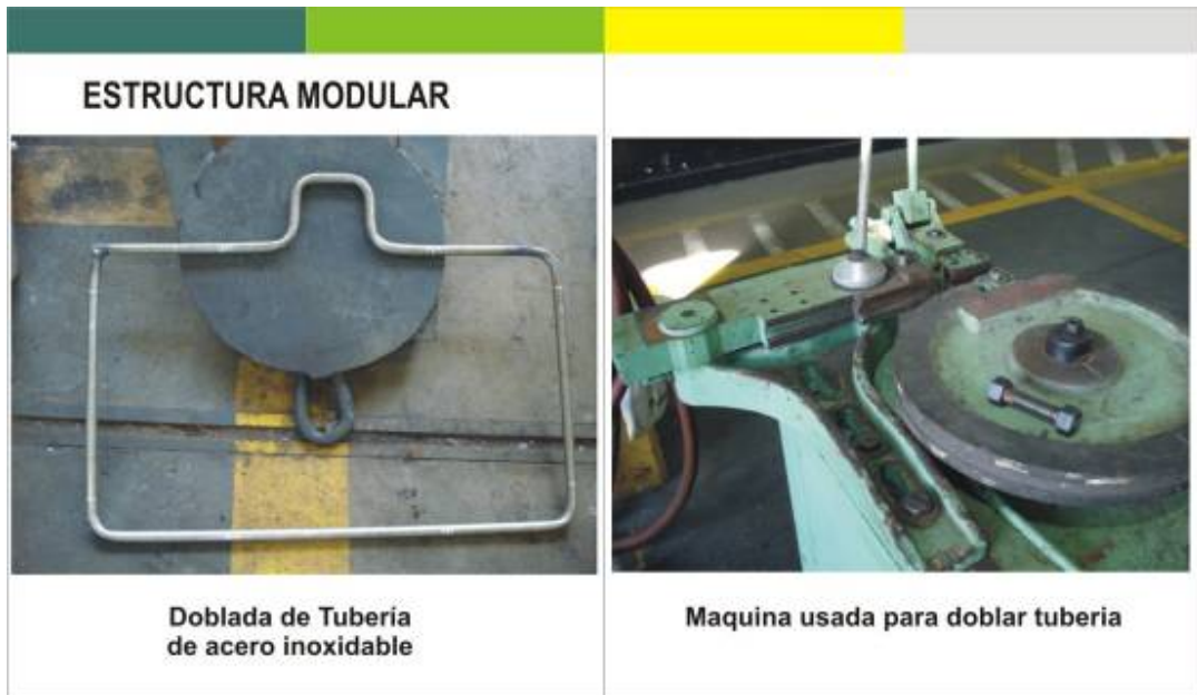
Figura143. Construcción de la estructura
