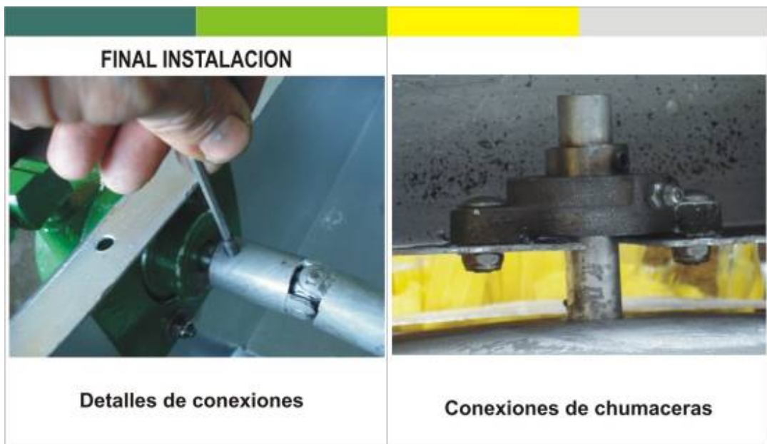
Figura 165. Instalaciones finales del modulo
