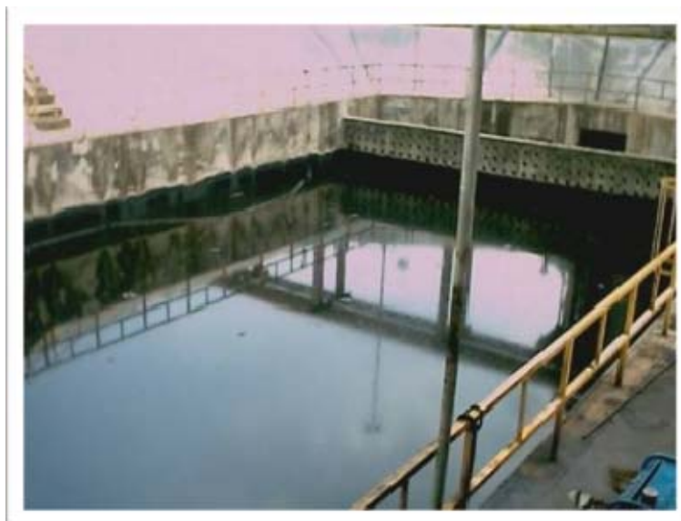
Figura 13. Piscina principal separador sur SE-3020
