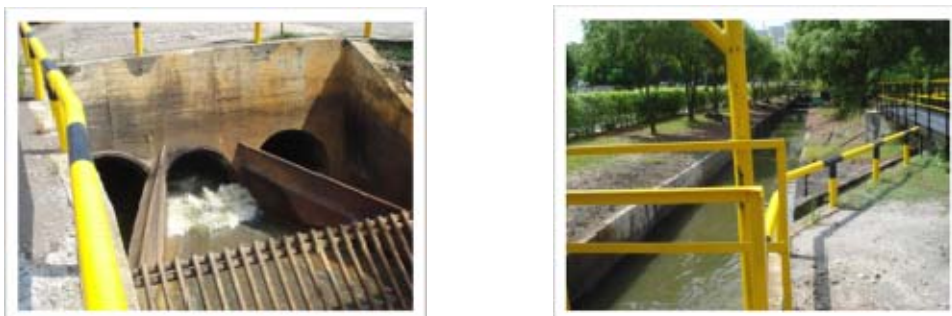
Figura 18 – 19 Primera etapa de la piscina pulmón retención del fluido
