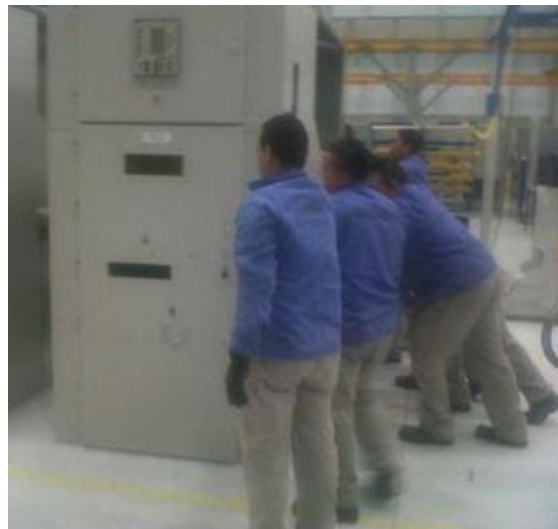
Figura N° 20: Movimiento celda por los operarios
