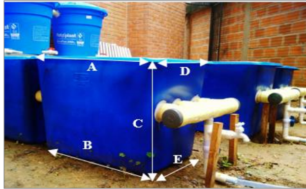
Figura 9. Contenedor que sirve de lecho impermeable.
