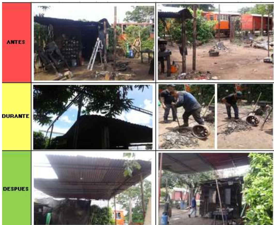
Figura 8. Procedimiento arreglo de filtraciones
