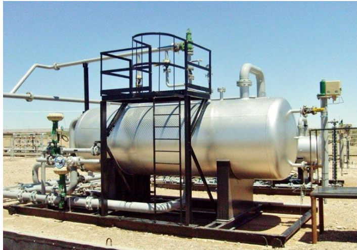
Figura 22. Separador horizontal.
