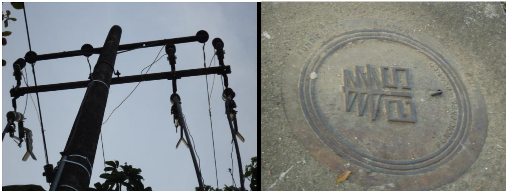
FIGURA 11. Fotografía del apoyo y Caja de Inspección de Piso.
