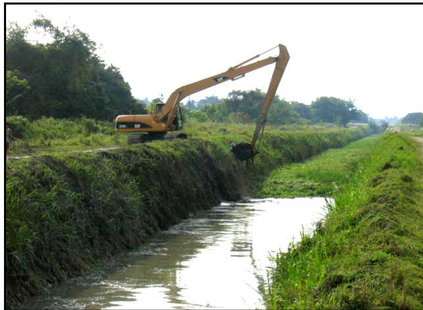
Figura 4. Excavadora Caterpillar 320 CL
