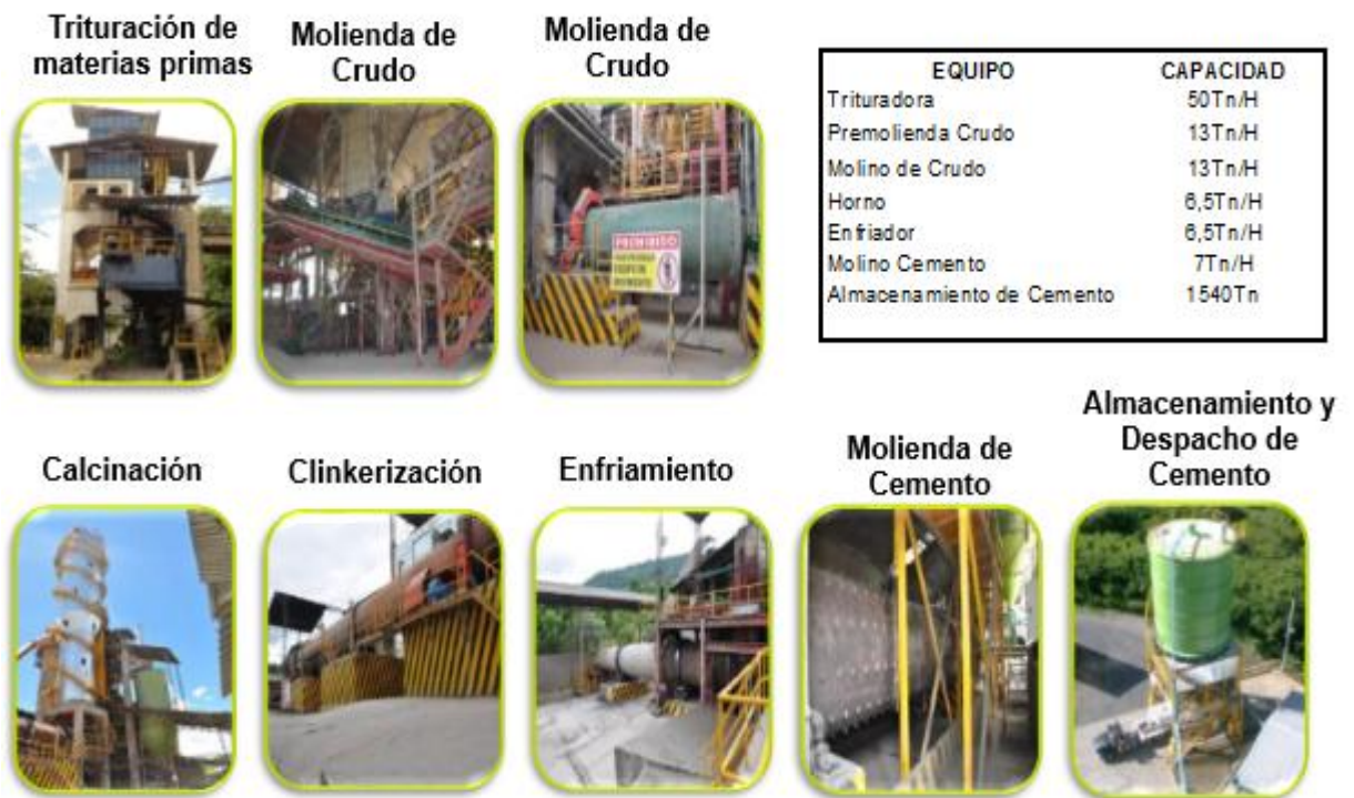
Figura 4. Equipos de la Planta.
