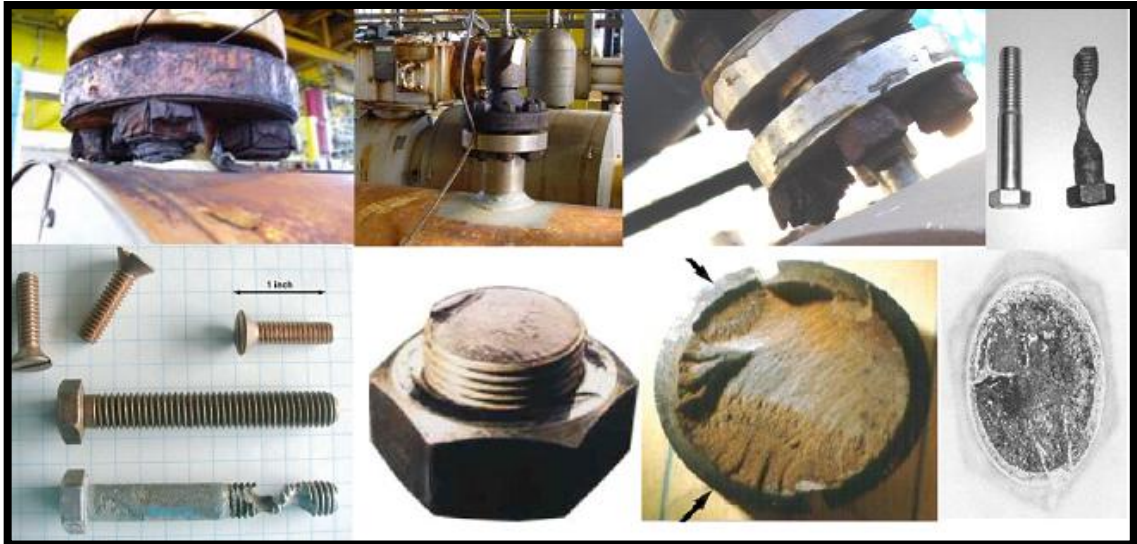
Figura 33. Consecuencias por corrosión en sujetadores
