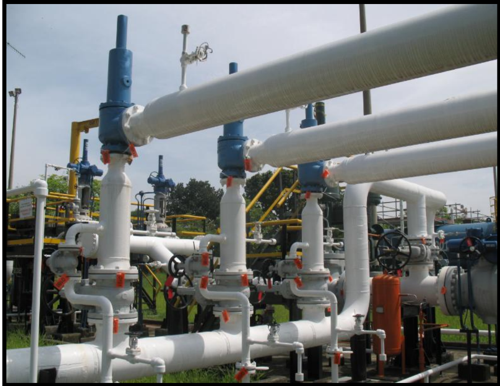
Figura 55. Registro Fotográfico 1 Instalación de Placas en Juntas
