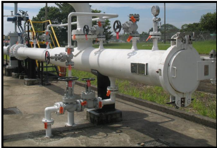
Figura 56. Registro Fotográfico 2 Instalación de Placas en Juntas
