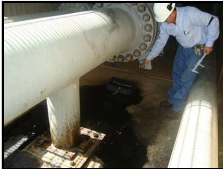
Figura 8. Fuga Brida 20x900 Julio del 2011 Estación Cusiana
