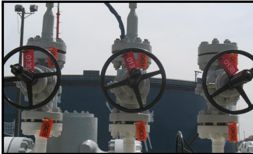
Figura 57. Registro Fotográfico3 Instalación de Placas en Juntas
