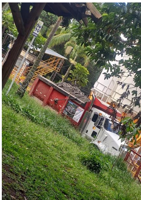
Figura 40 Salida de escombros a reprocesar
