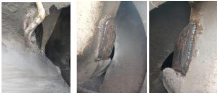
Figura 34 Inserción de la lámina de contención 1
