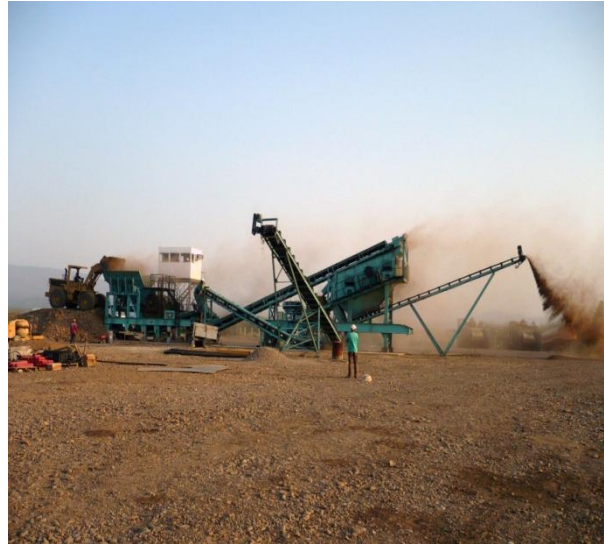
Figura 3.1. Contaminación atmosférica de una planta trituradora.
