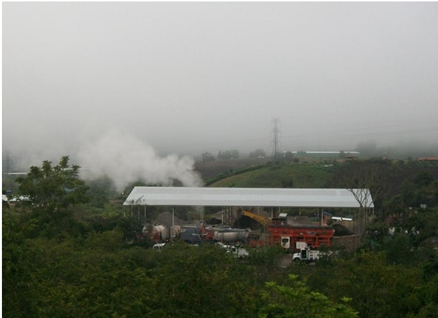
Figura 3.4. Contaminación atmosférica de una planta de asfalto.
