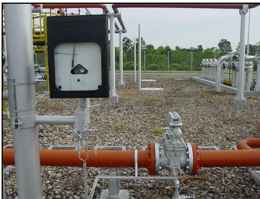
Figura 6.3 Medidor diferencial platina de orificio
