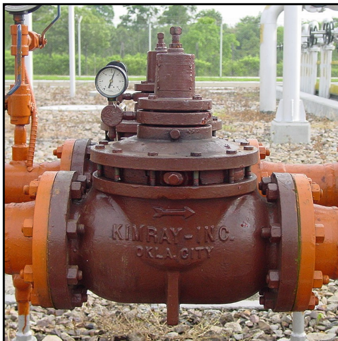
Figura 6.12 Válvula Autorreguladora de Presión “Kimray”
