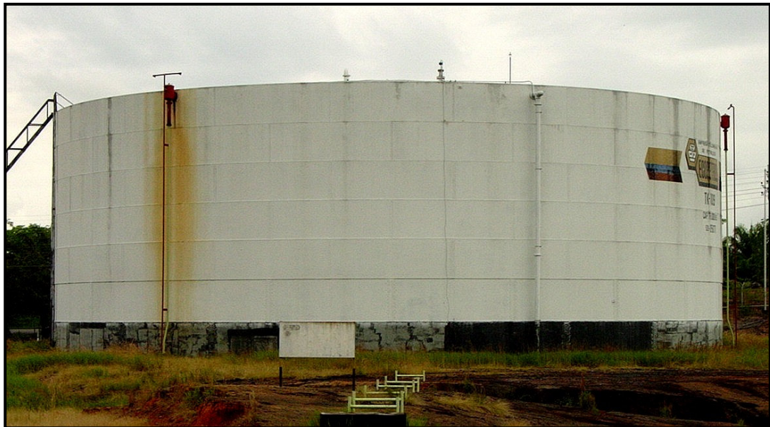
Figura 7.28 Tanque de Fiscalización TK-109
