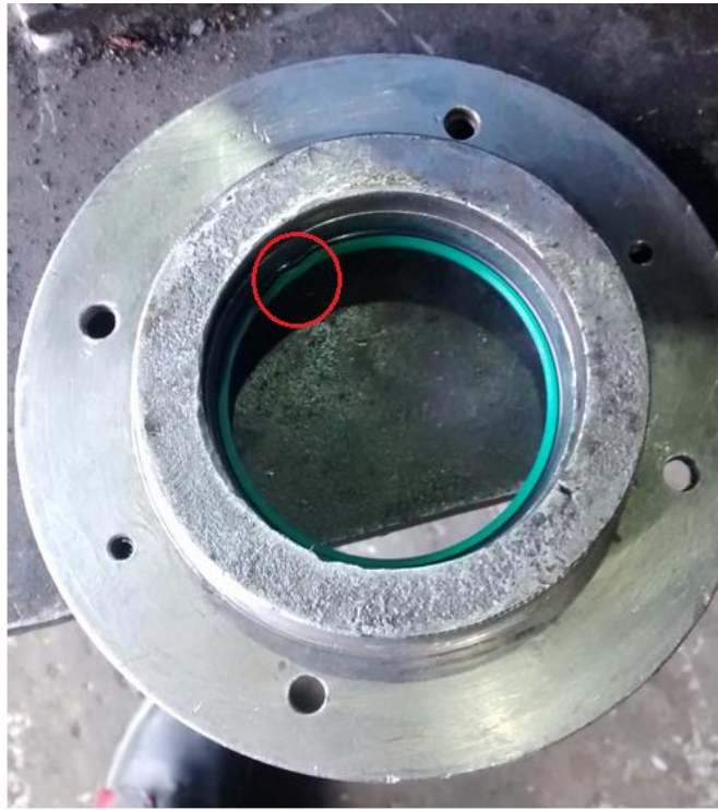
Figura 21 Daño retenedores cabezote
