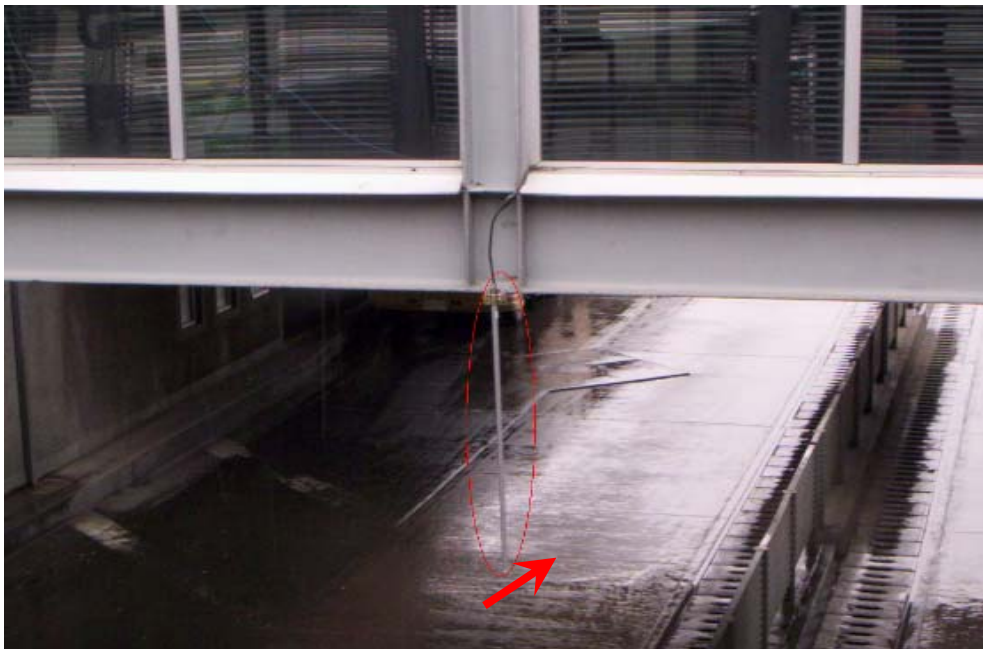
Figura 14. Antena Omni instalada en Portal Norte
