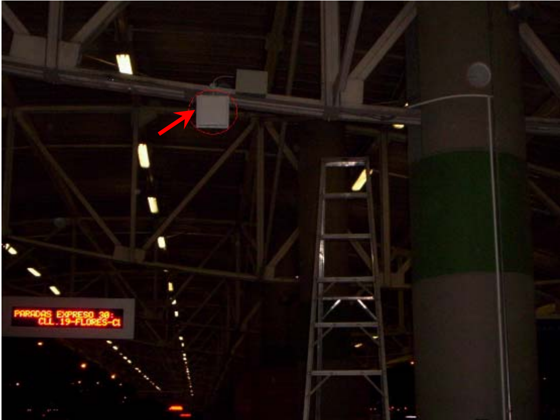
Figura 21. Antena Panel instalada en Portal del Tunal (segunda vista)
