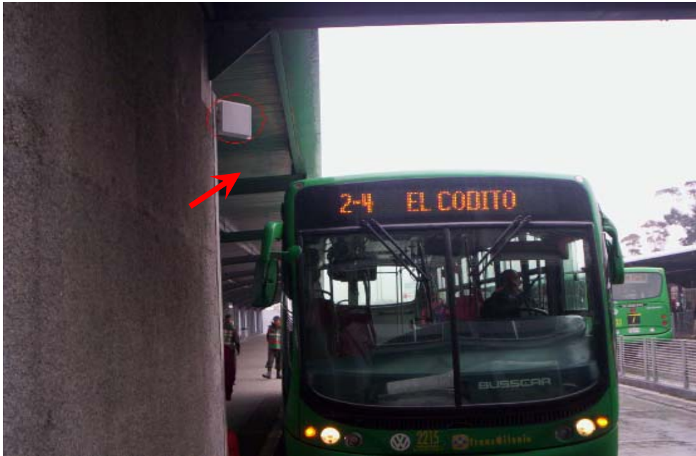
Figura 13. Antena Panel instalada en Portal Norte (segunda vista)
