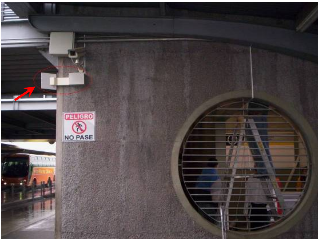
Figura 12. Antena Panel instalada en Portal Norte
