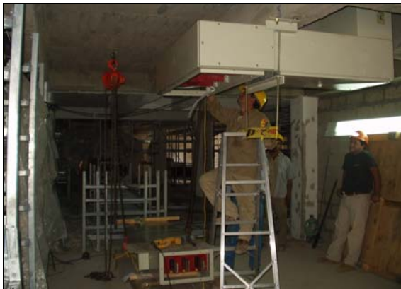
Figura 3.15. Instalación Ducto Baja Tensión
