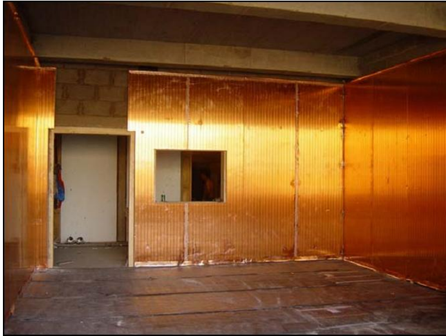
Figura 39. Figura Jaula de Faraday sala de exploración.
