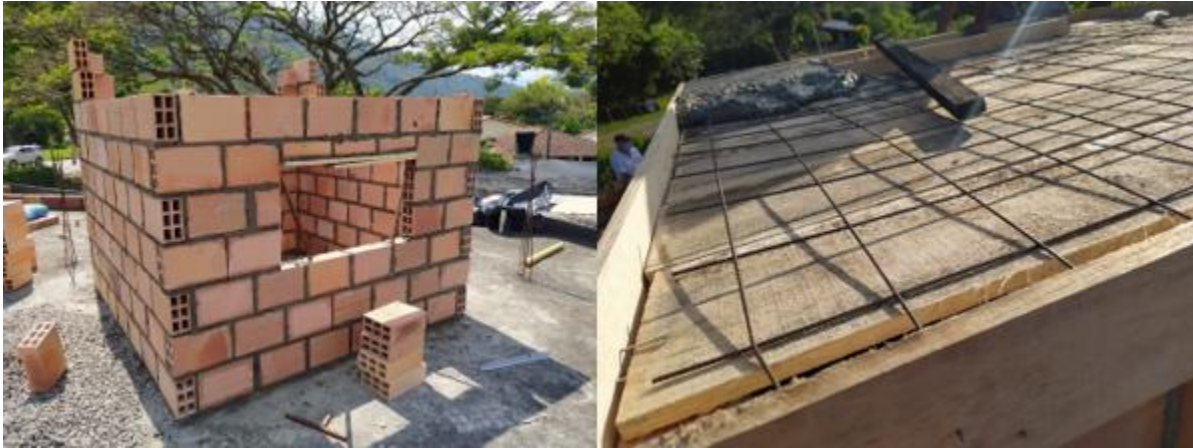
Figura 11. Construcción recinto de la Chimenea Solar
