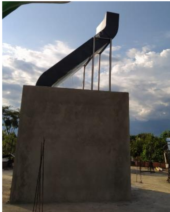
Figura 11. Construcción recinto de la Chimenea Solar
