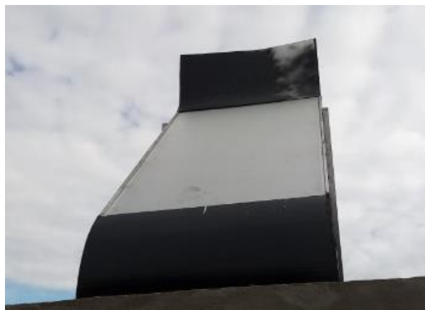
Figura 9. Vidrio y pintura negra de la estructura de la chimenea solar
