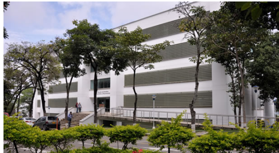
Figura 4. Edificio de Estudios Industriales y Empresariales de la UIS.
