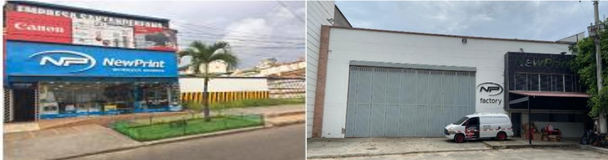
Fachada de las sedes de Maxprinter en Bucaramanga y Girón
