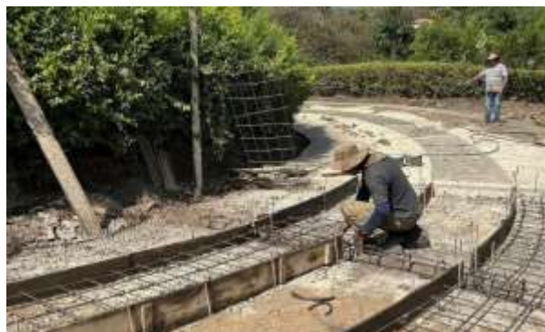
Figura 2 Visita ocular construcción placa huella. Fuente: El Autor (2026)
