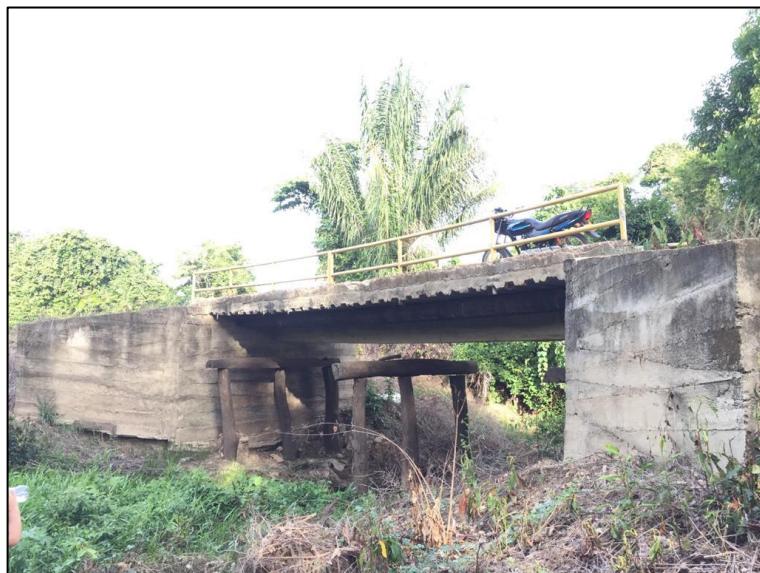
Figura 19. Puente en concreto en regular estado.
