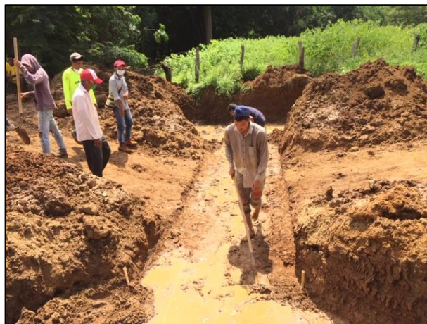
Figura 12. Excavación manual, construcción Box-Culvert.
