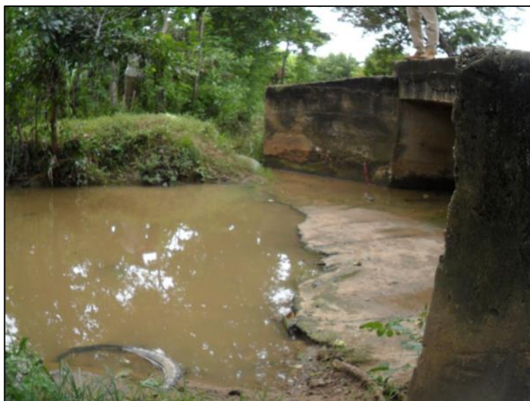
Figura 9. Encole box culvert.
