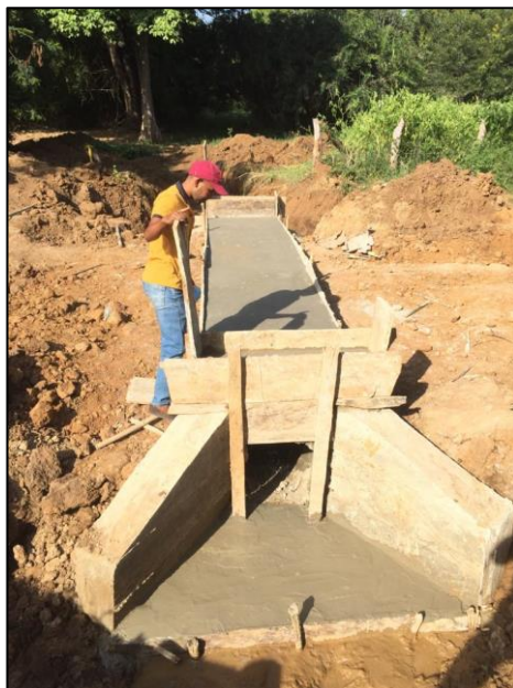
Figura 14. Fundición placa superior.
