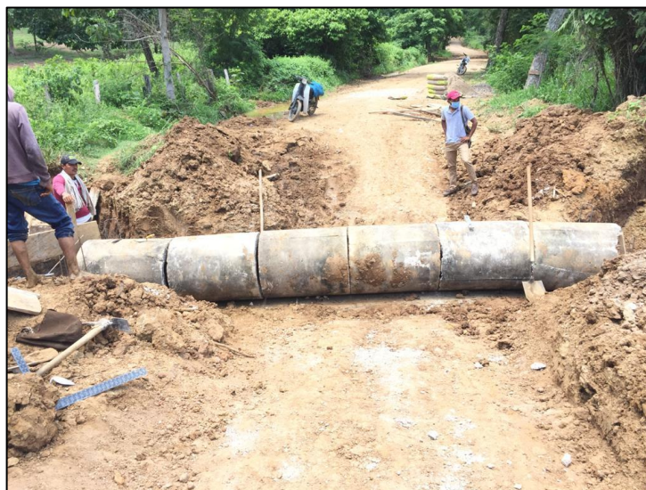
Figura 13. Instalación de anillos en concreto reforzado.
