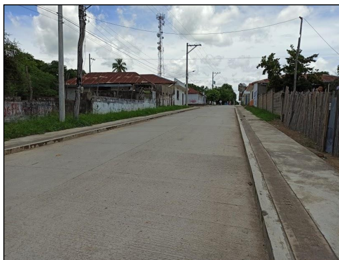
Figura 27. Ausencia resalto carrera 2 Astrea.
