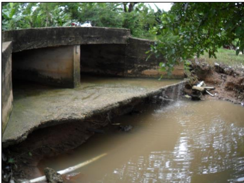
Figura 10. Descole box culvert.
