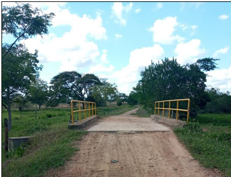
Figura 18. Puente en concreto en buen estado.
