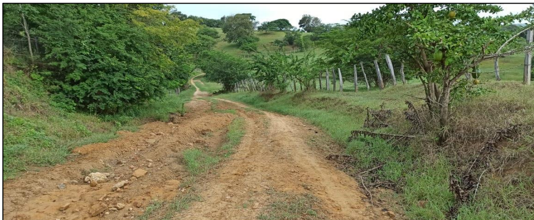
Figura 16. Tramo critico # 5, vía Astrea – La Siria – Montebello
