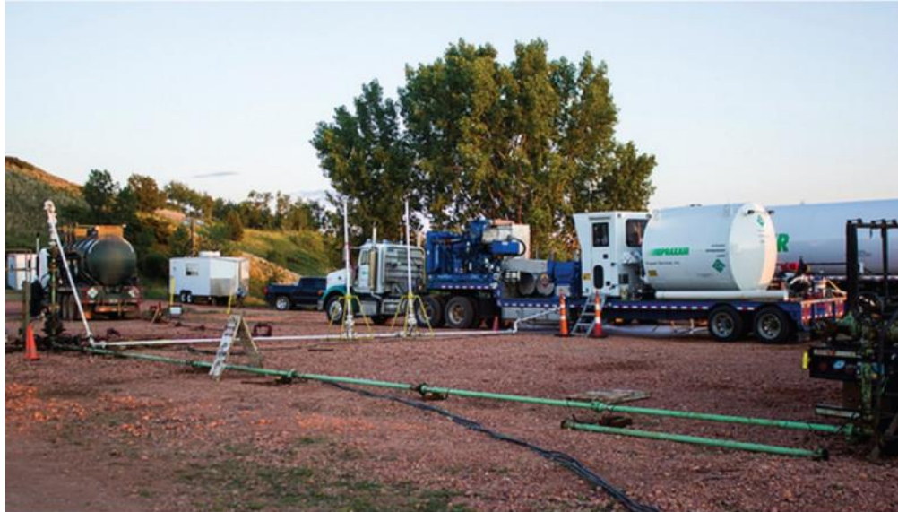
Figura 61. Prueba de Campo Inyección de CO 2 , Middle Bakken.
