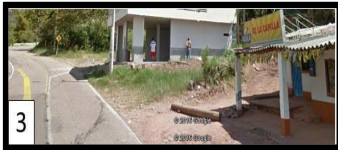
Figura 21. Ubicación del punto 3 “Caseta la Capilla”.
