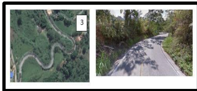
Figura 6. Identificación de la curva en el punto 3
