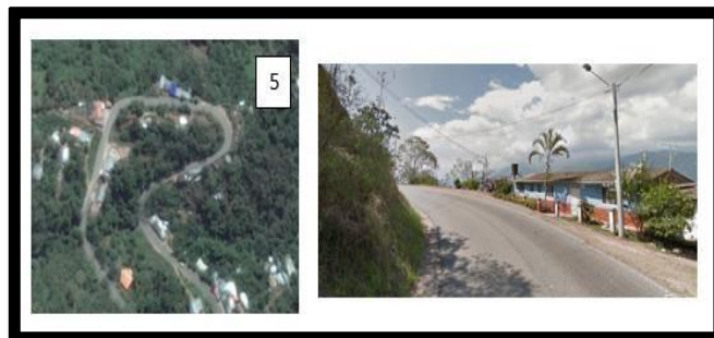
Figura 8. Identificación de la curva en el punto 5
