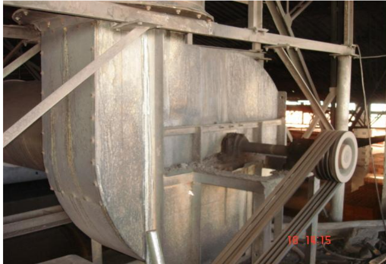
Figura 20. Ventilador Centrífugo.
