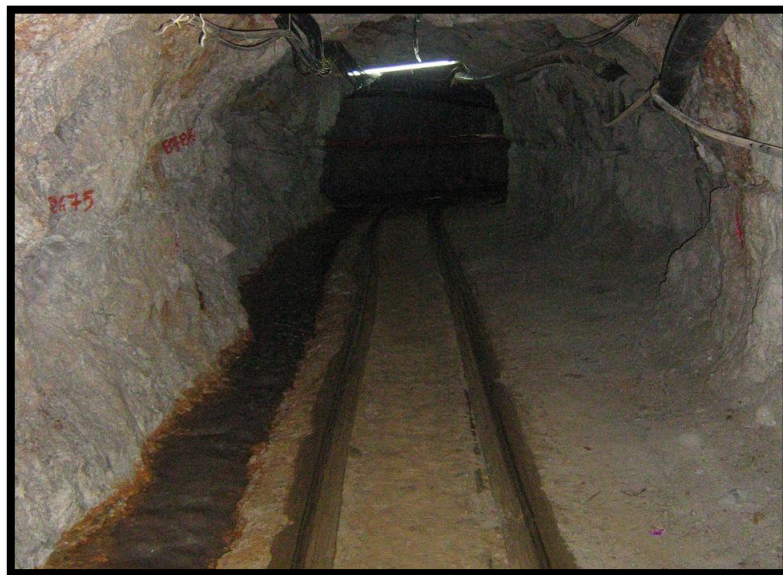
Foto 5. Interior túnel exploratorio la Perezosa
