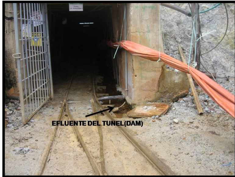
Foto 4. Boca mina túnel exploratorio la Perezosa
