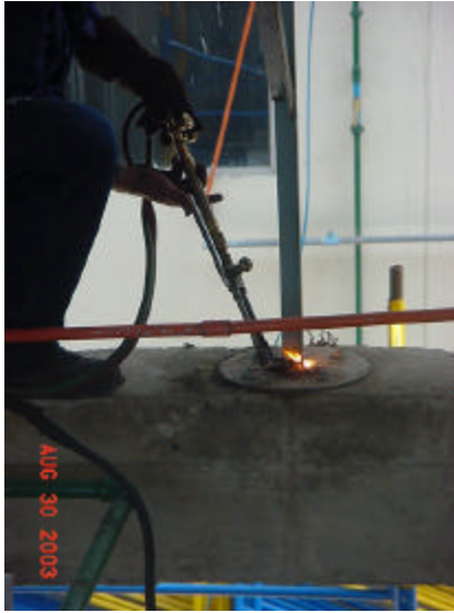
Figura 6: Corte con oxicorte. Desmontaje de soportería
