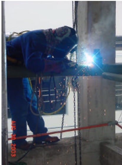
Figura 25: Soldadura por arco eléctrico revestido. Montaje de línea de conducción de amoníaco. Freskaleche - Bucaramanga
