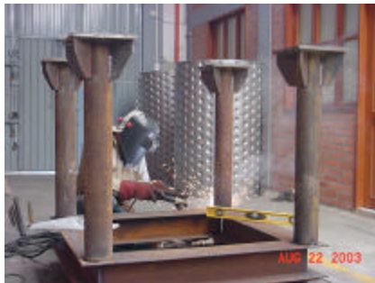
Figura 17: Soldadura eléctrica por arco revestido. Fabricación de estructura soporte para bandas transportadoras
