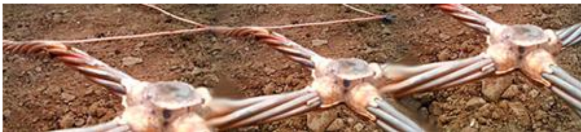
Figura 16. Malla de puesta a tierra.
