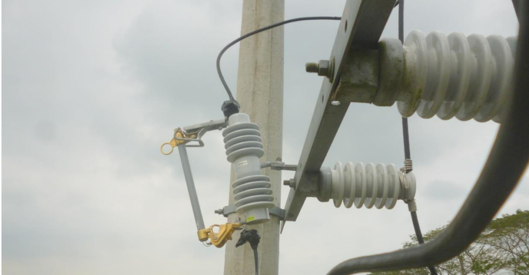
Figura 26. Cajas cortacircuitos.
