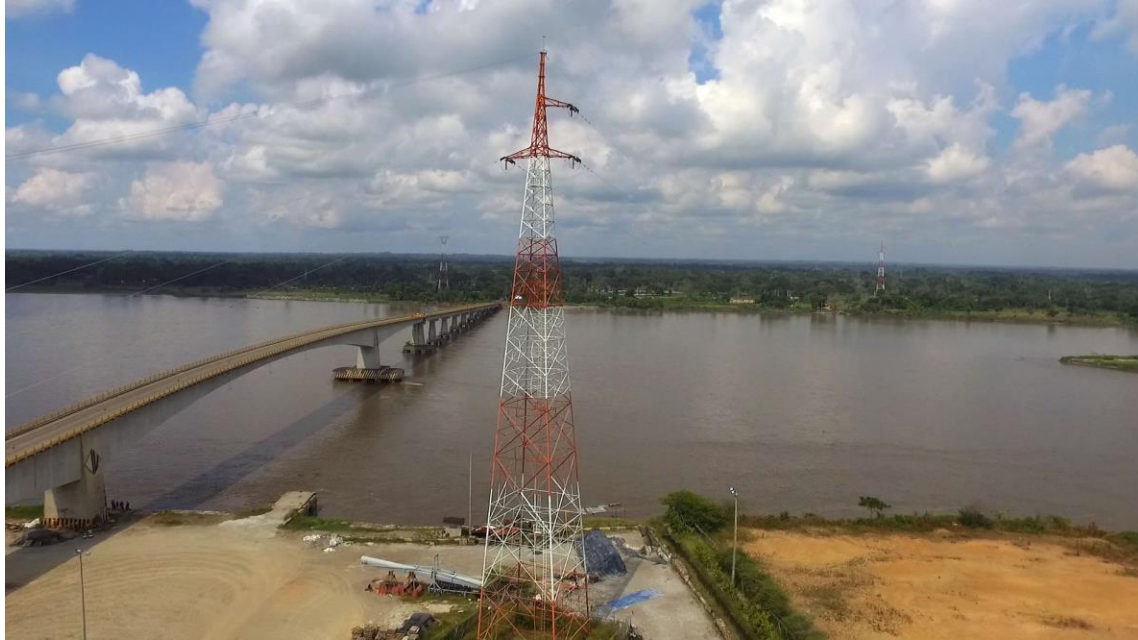
Figura 28. Torre de transmisión eléctrica.
