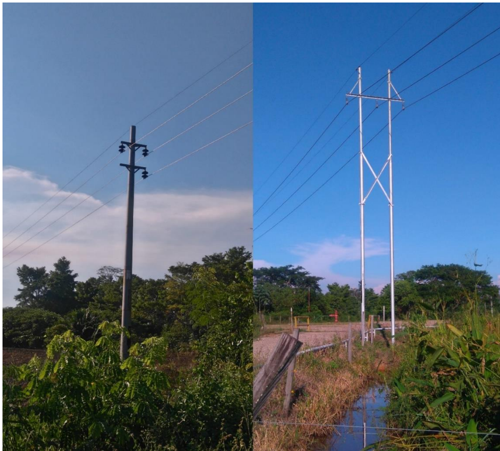
Figura 8. Estructura de suspensión en S y SH.
