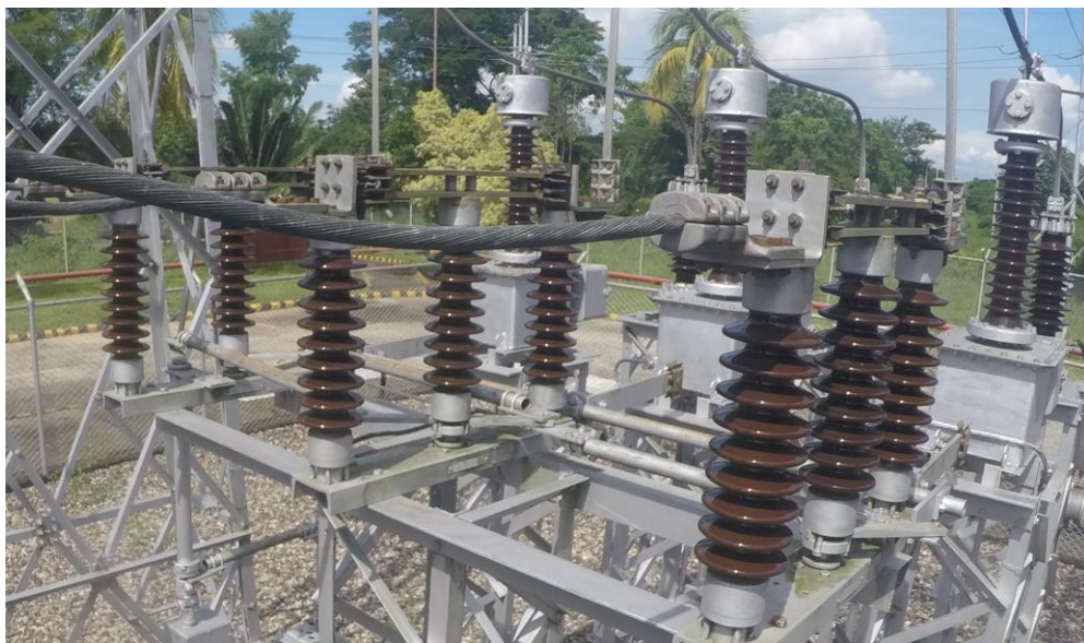
Figura 20. Seccionador.
