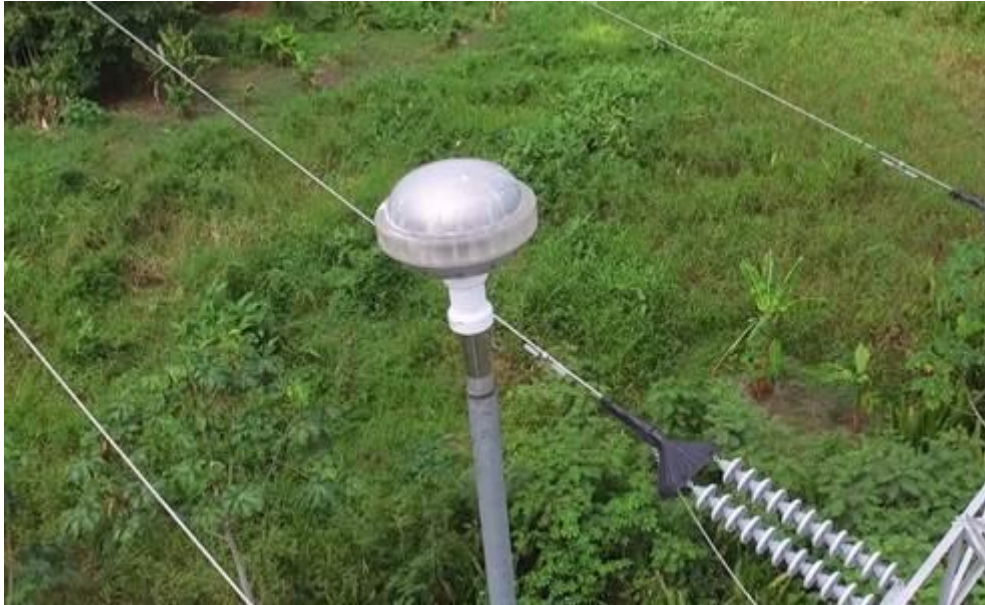
Figura 18. Pararrayo desionizante.
