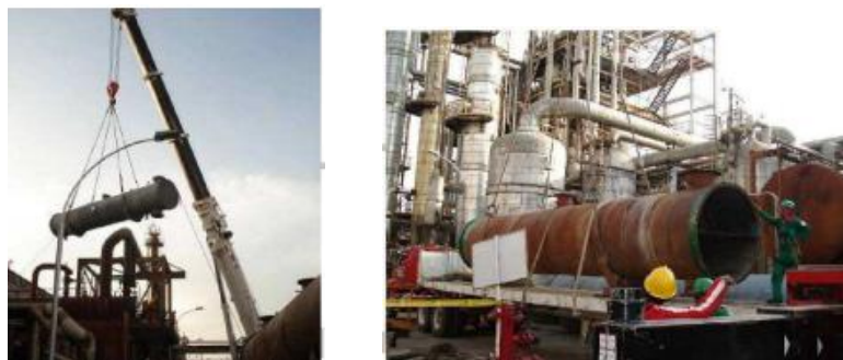
Figura 1 Fotografías de trabajos realizados por CIMELEC LTDA.
