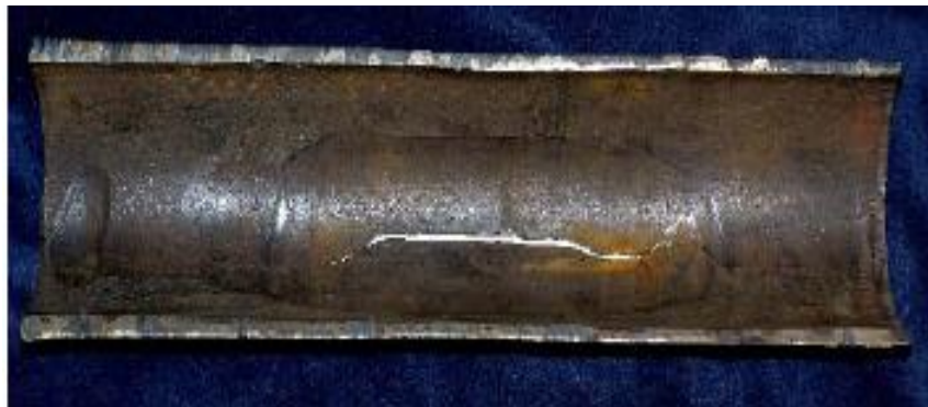
Figura 8.1 Grieta en la tubería por rozamiento
