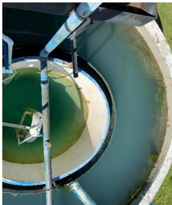
**Filtración:** La filtración se realiza mediante la utilización inicial del filtro ubicado en la parte interior del tanque de la planta compacta mediante flujo ascendente ver Figura 8. El lecho está conformado por grava, arena y antracita. El agua filtrada se recolecta por una tubería de rebose de 4", la cual conduce el agua a un nuevo filtro circular de lámina de acero. El material filtrante es arena y antracita. Las dimensiones son de 3 m de diámetro y 4 m de altura.
