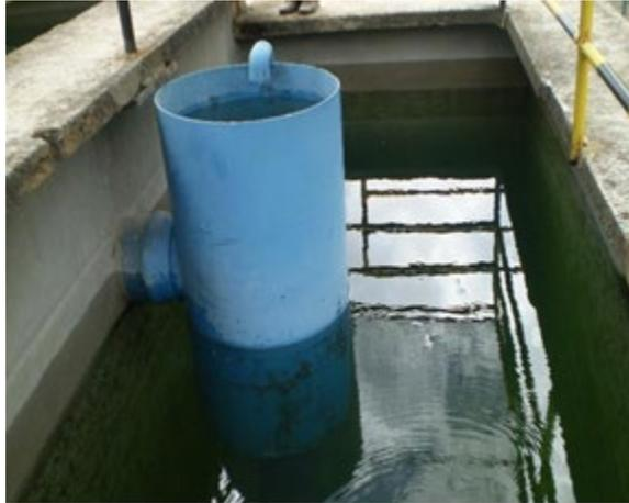
**Desinfección:** El proceso de desinfección se realiza aplicando cloro gaseoso en el tanque de almacenamiento mediante un dosificador automático ver Figura 17.
