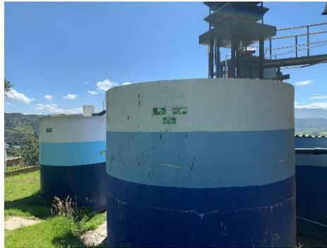
**Desinfección:** El proceso de desinfección se realiza aplicando cloro gaseoso en el tanque de almacenamiento mediante un dosificador automático ver Figura 9.
