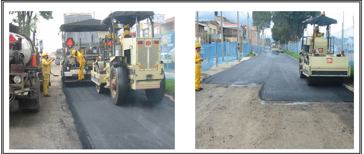
Figura 32. Colocación mezcla proceso vía Húmeda– febrero de 2004
