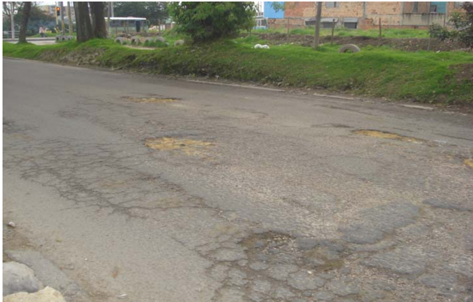
Fuente: fotografía tomada por los autores septiembre de 2010.
