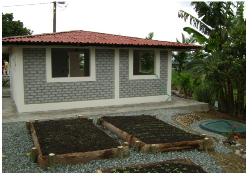
Figura 50. Fotografía de la Eco-casa – con ladrillo a la vista
