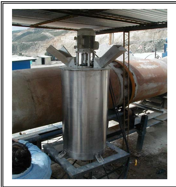
Figura D10 al anexo No. 4 Base del reactor anclada en la placa
