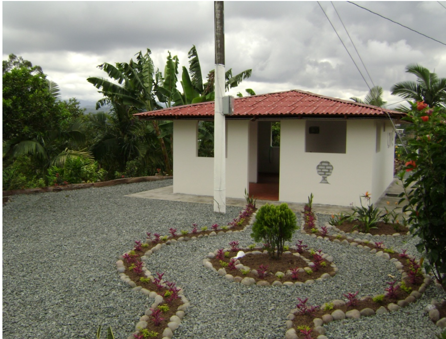
Figura 51. Fotografía de la Eco-casa - terminada
