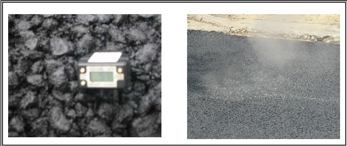
Figura 31. .Colocación mezcla proceso vía seca– febrero de 2004
