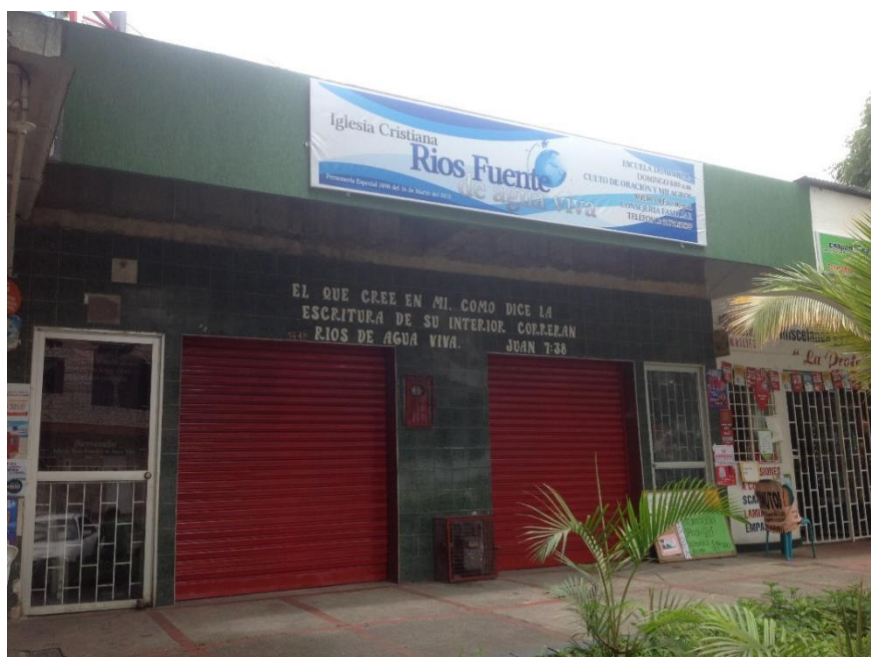
Figura 93. Fachada de Iglesia Cristiana Ríos Fuentes de Agua Viva, ubicada en Bucaramanga, Santander. Elaboración propia.
