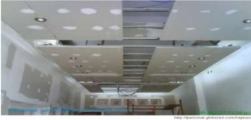
Figura 8. Construcción Liviana en terminación 71
