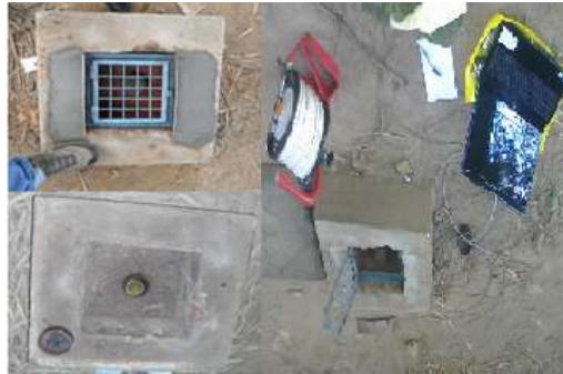
Figura 13. Antes y después de la seguridad de los piezómetros.
