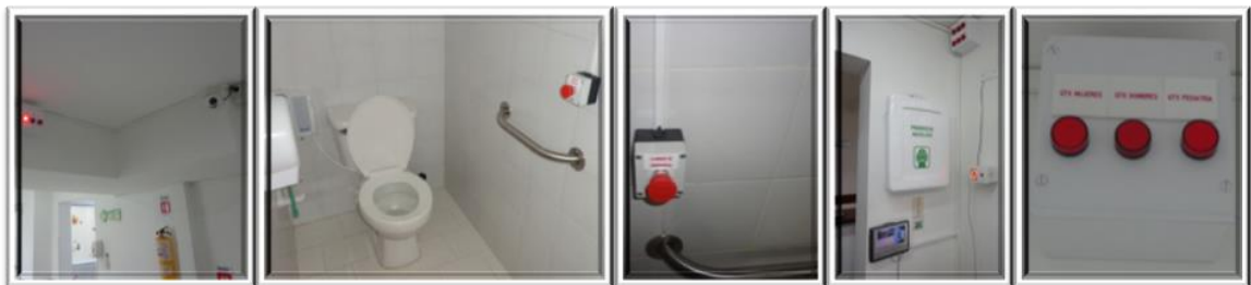
Imagen 12. Timbres instalados en los baños de los servicios
