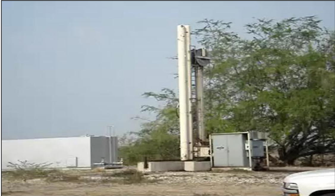
Figura 20. Unidad de bombeo DynaPump
