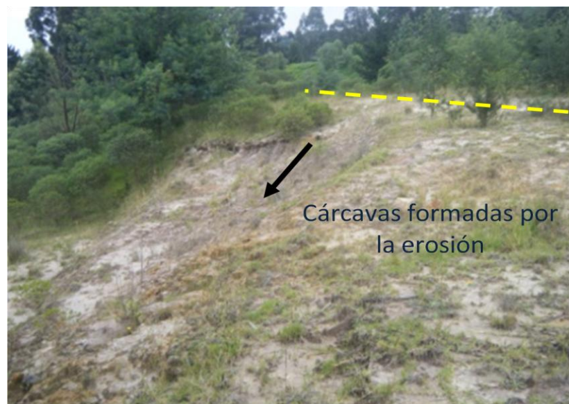
Figura 13. Derecho de vía erosionado
