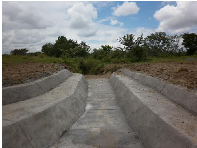
Figura 17. Canal trapezoidal en concreto
