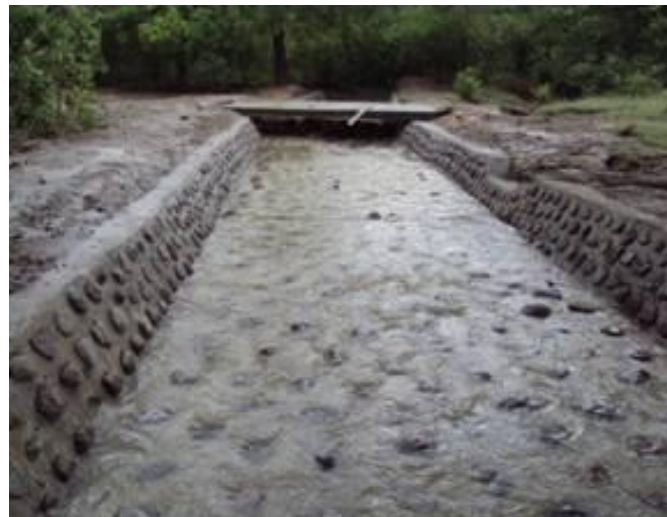
Figura 18. Canal trapezoidal en piedra pegada
