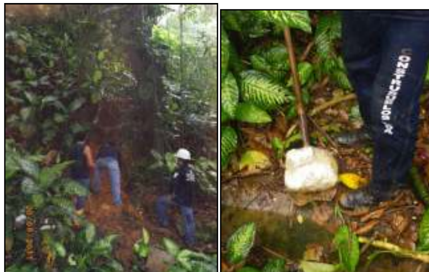
Ilustración 17. Ejecución Apique 2. Parte media del talud
