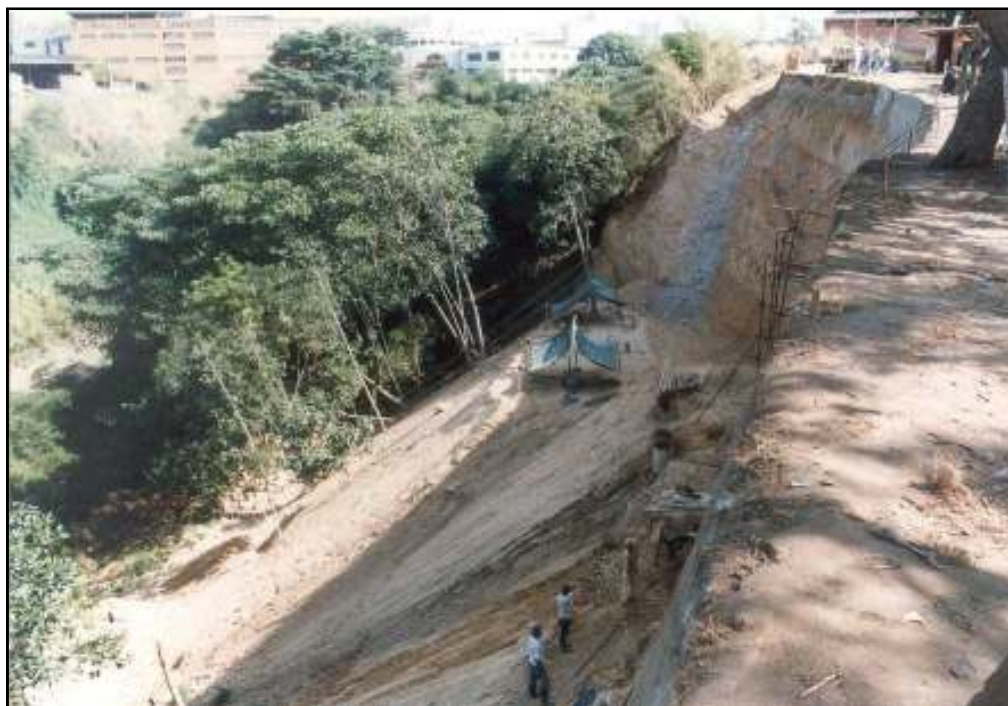
Ilustración 13. Construcción Pantalla Anclada - Año 1995
