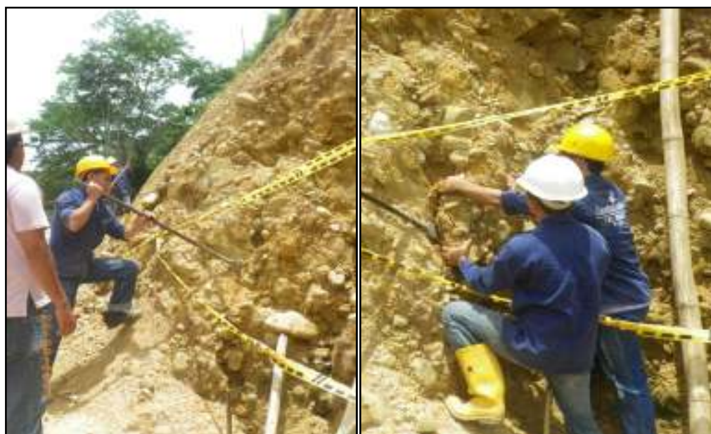
Ilustración 18. Ejecución Apique 3. Pie del talud
