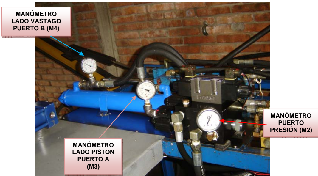
Figura 3.39. (a) Disposición de los manómetros en el circuito hidráulico modular.
