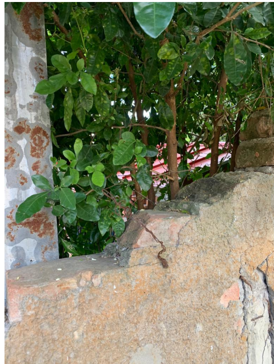
Imagen 4. Evidencia de la caseta encontrada al otro lado del muro.
