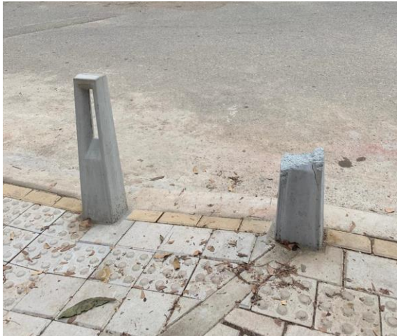
Imagen 1. Bolardo deteriorado
