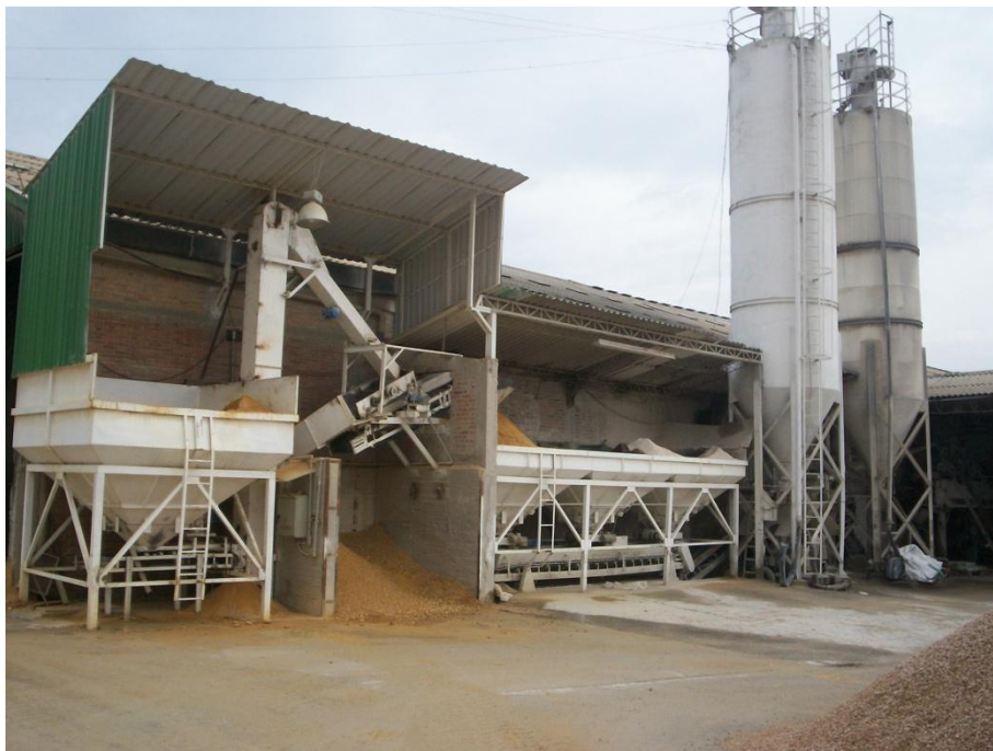
Figura 5. Sistema de mortero
