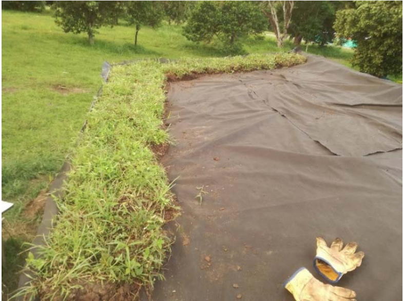
Figura H2. Inicio de montaje de techo verde.
