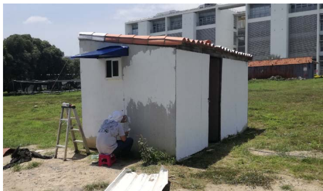
Figura 61. Instalación del Alero y proceso de pintado.
