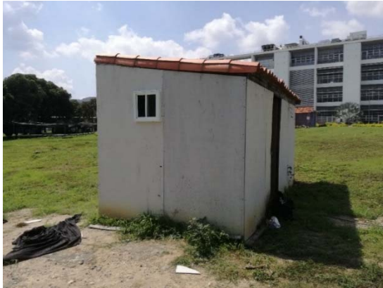
Figura 59. Instalación de la ventana izquierda.
