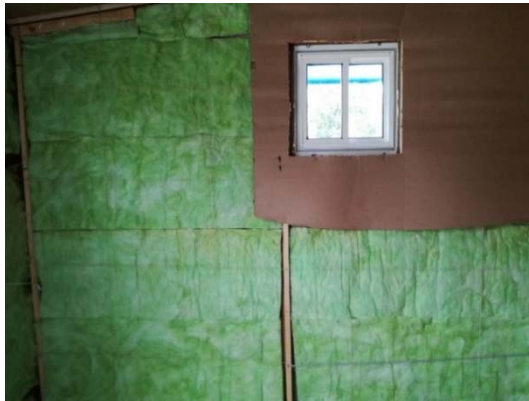
Figura 60. Aplicación del aislante en la pared izquierda.
