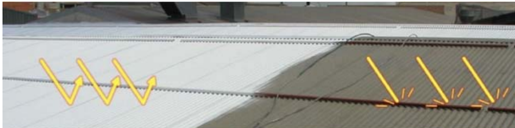
Figura 13. Aplicación de pintura térmica reflectora.
