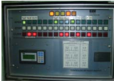
Figura 57. Fotografía del estado de las válvulas en el momento de la lectura del mapa de memoria
