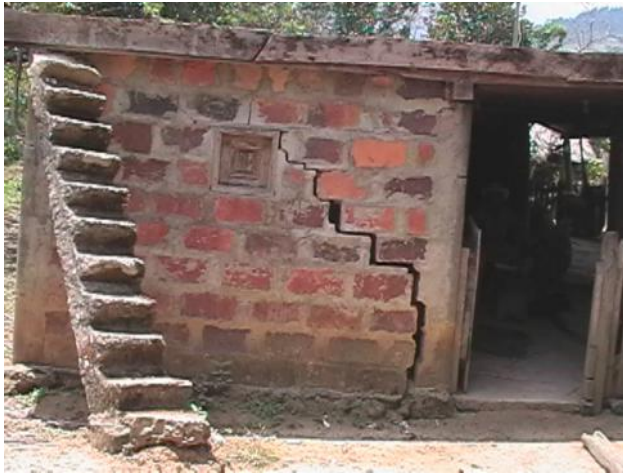
Figura 36. Vivienda agrietada y desestabilizada por movimiento del suelo debido a una prospección sísmica realizada en San Vicente de Chucurí, Santander.
