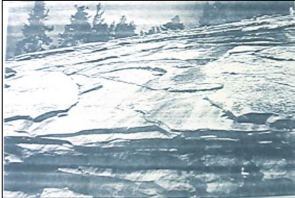
Figura 13. Exfoliación producida por pérdida del material suprayacente.
