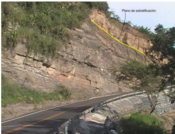
Figura 17. Planos de estratificación, uno aparece señalado. Carretera San Gil – Socorro. Santander. Fuente: Autor.
