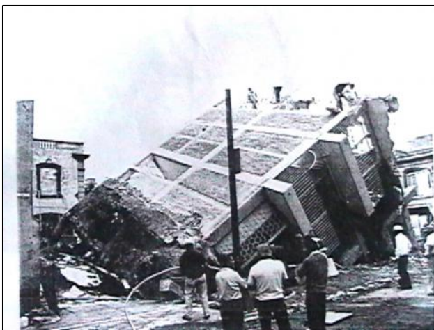
Figura 24. Efecto de la licuación sobre las construcciones.
