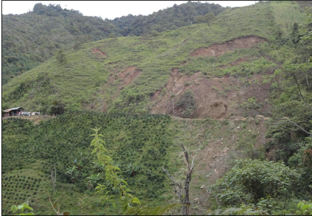
Figura 21. Deslizamiento traslacional ubicado en la vereda La Lindosa, Sector: El Espejo.; vía alterna que comunica al Cgto. San Luis (Huila) con el municipio de Planadas (Tolima).
