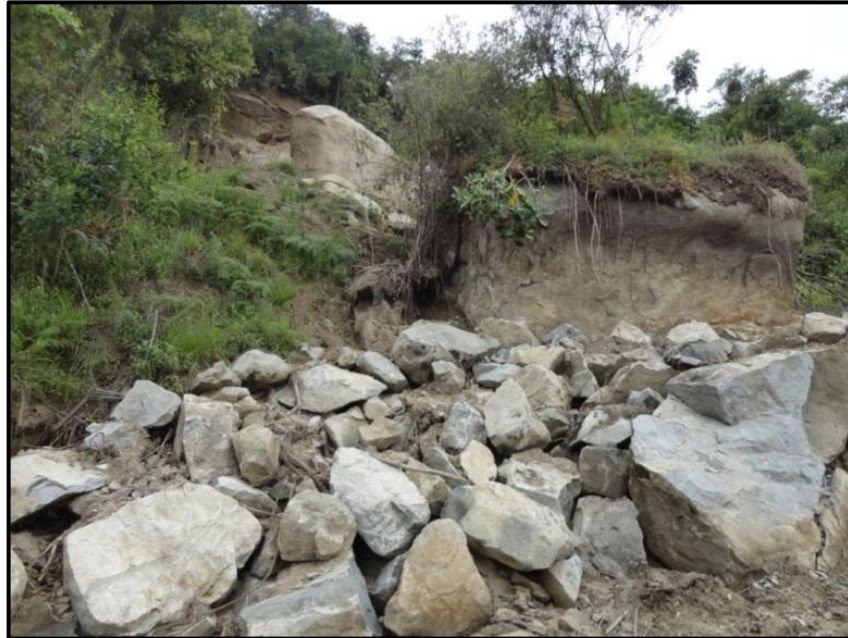
Figura 23. Caída de rocas ubicado en el margen izquierdo de la carretera que comunica el municipio de Palermo con el Corregimiento de San Luis en la Vda. El Piñuelo.
